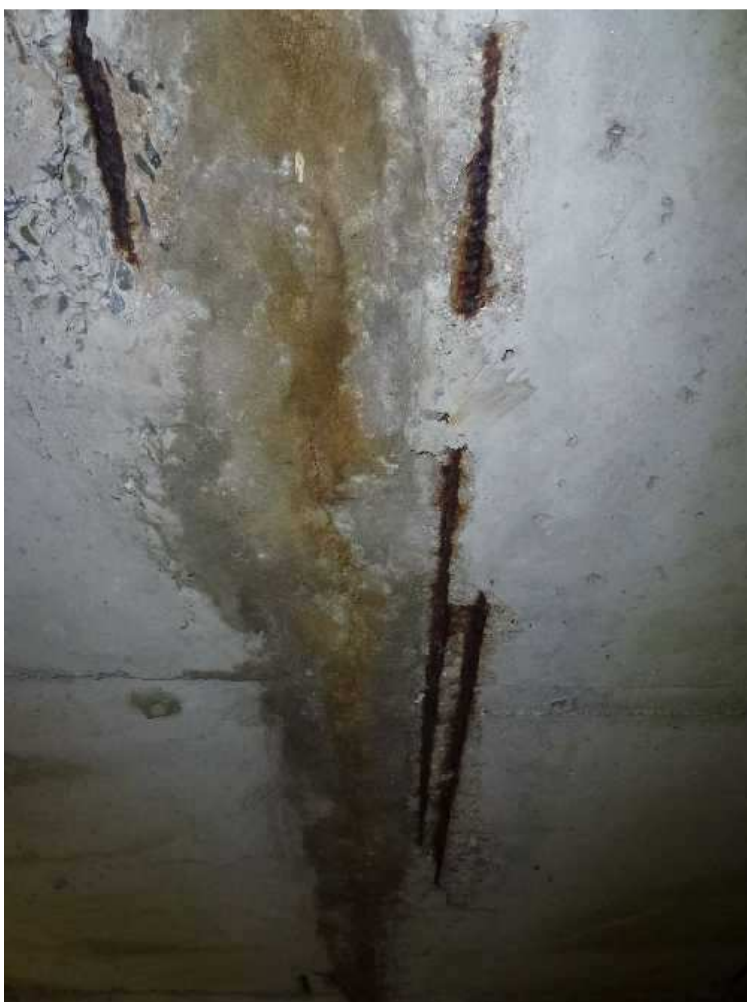
Korodující výztuž na stropě.
