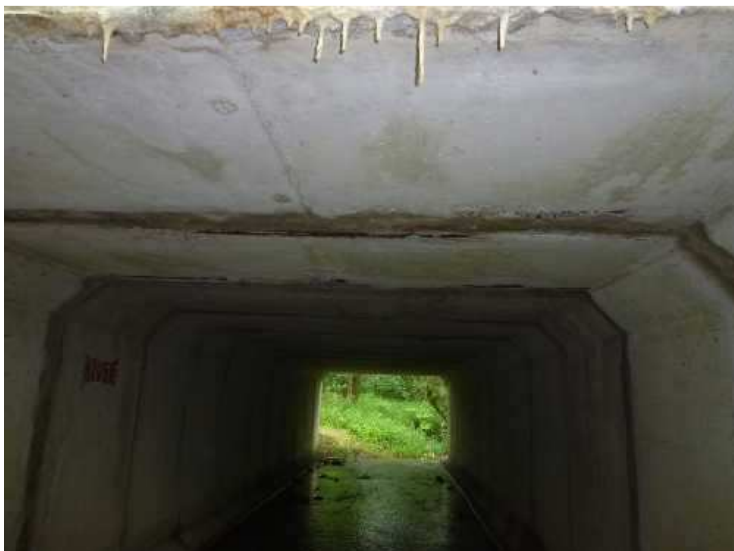
Pohled na strop. Na levém kraji mostu jsou krápníky. Spáry zatékají.
