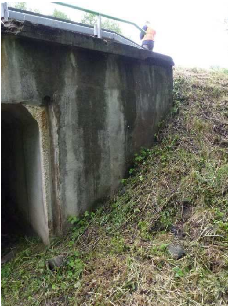
Pravé křídlo opěry 2. Zatékání mezi rámem a křídlem. Poškozená římsa.
