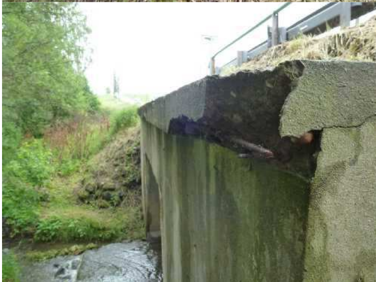
Pravá římsa má olámané hrany, na konci mostu je beton odpadlý a výztuž odkrytá.
