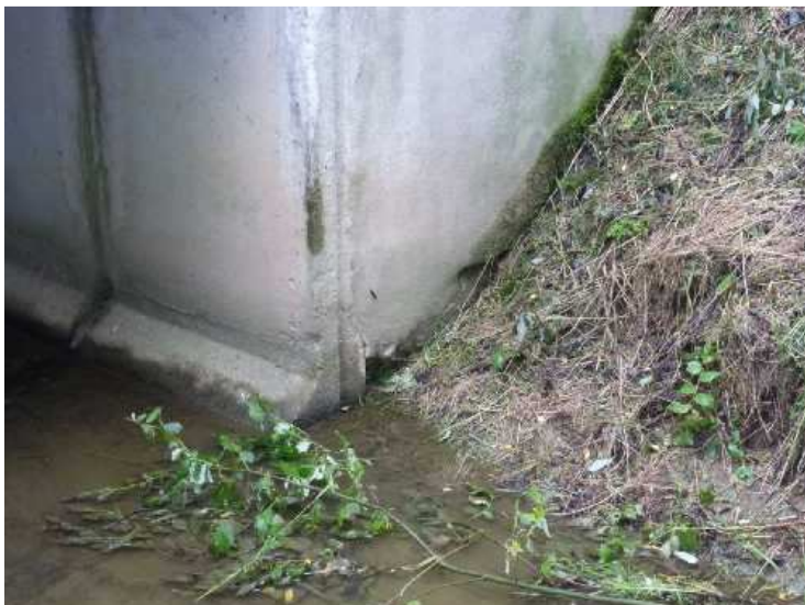
Poškozený beton na spodní části křídla opěry 1 vlevo.
