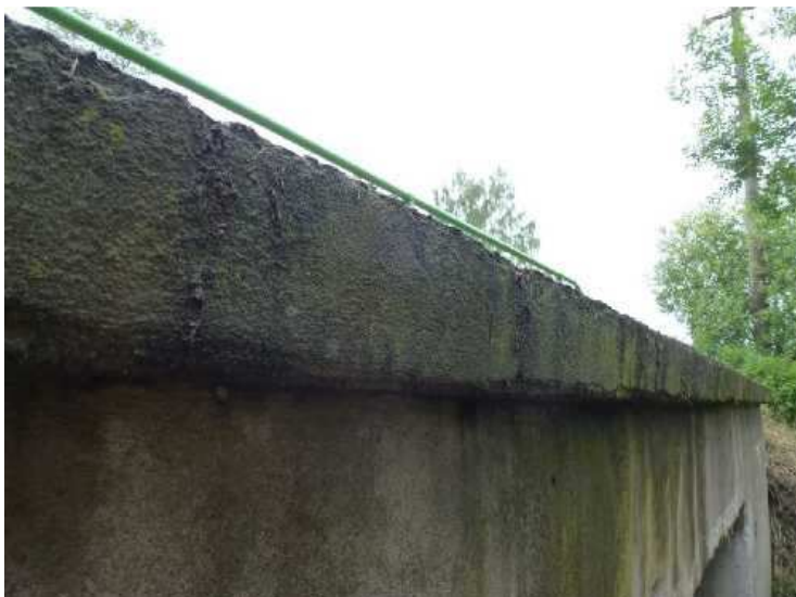
Levá římsa porostlá mechem, povrch degradovaný, hrany olámané.
